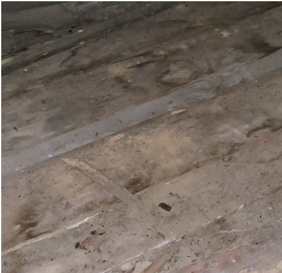
Fot. 13. Podłoga z desek ze śladami zawilgocenia i uszkodzeniami spowodowanymi przez ksylofagi.
