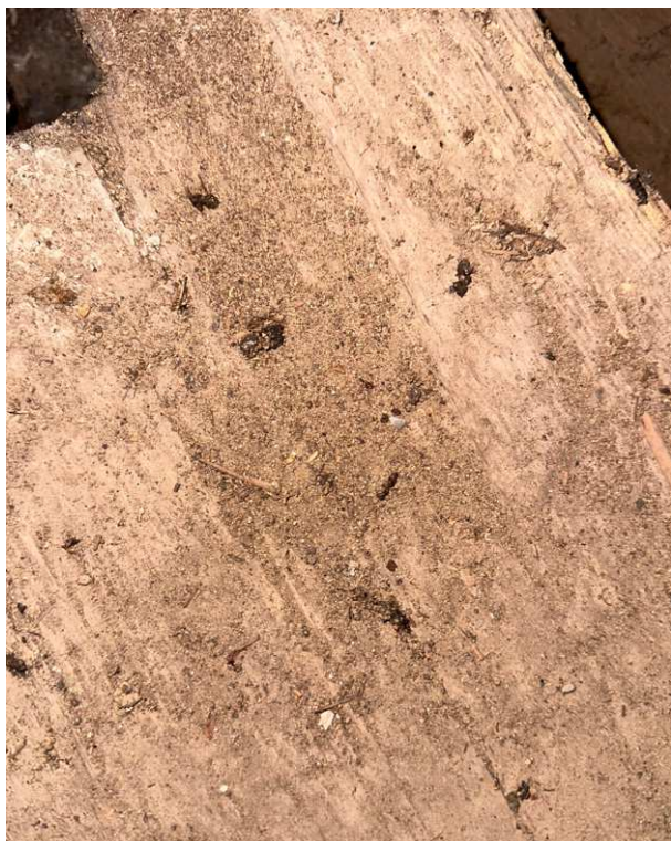
Fot. 10. Sypiące drewno z odchodami świadczące o czynnym żerowisku ksylofagów – podłużna belka między słupami (strefa przypodporowa).
