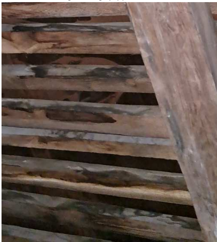
Fot. 5. Zawilgocenia i grzyby pleśniowe na deskowaniu dachowym i krokwi.
