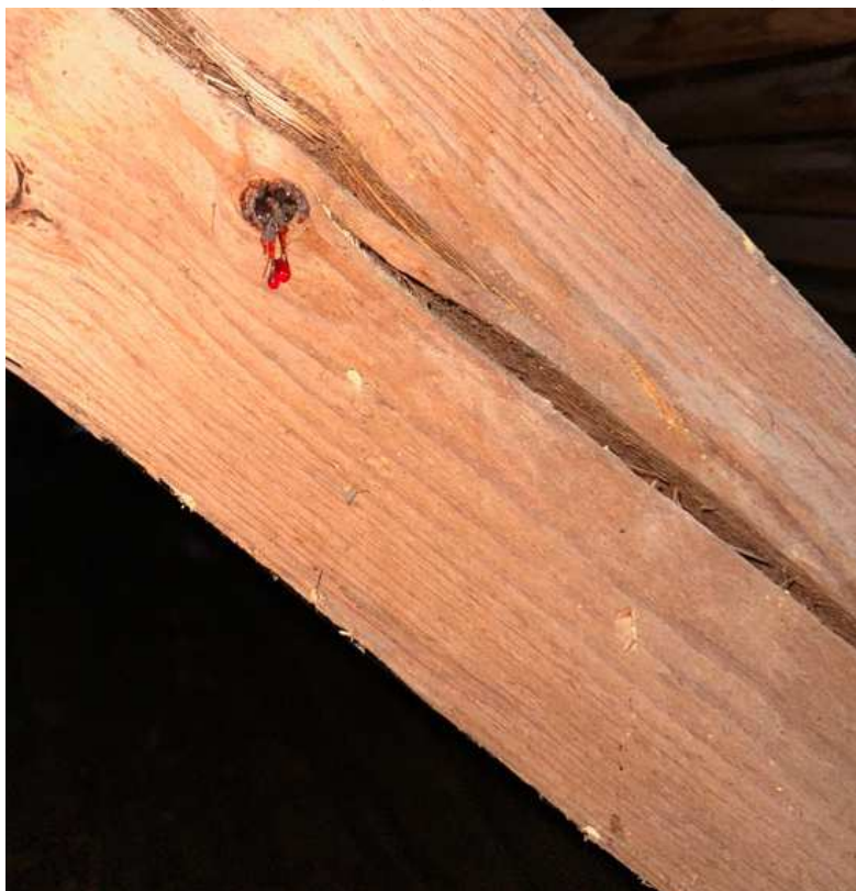
Fot. 7. Krokiew ze śladami obecności kołatka domowego.
