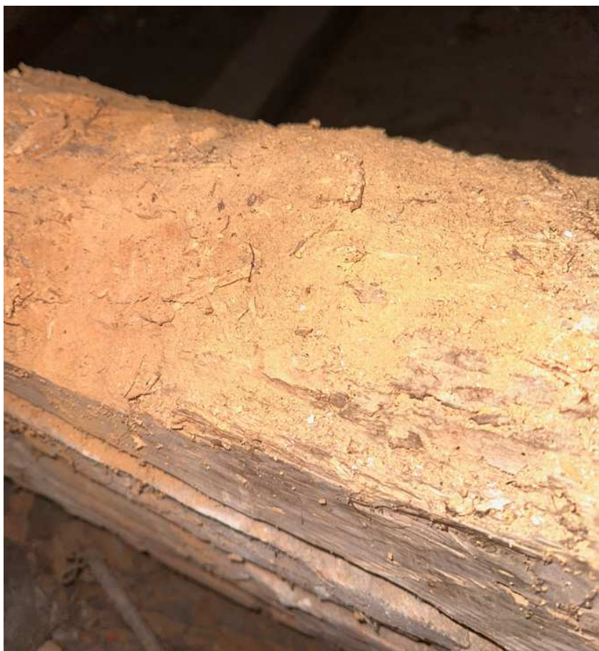
Fot. 8. Sypiące drewno z odchodami świadczące o czynnym żerowisku ksylofagów – podłużna belka między słupami
