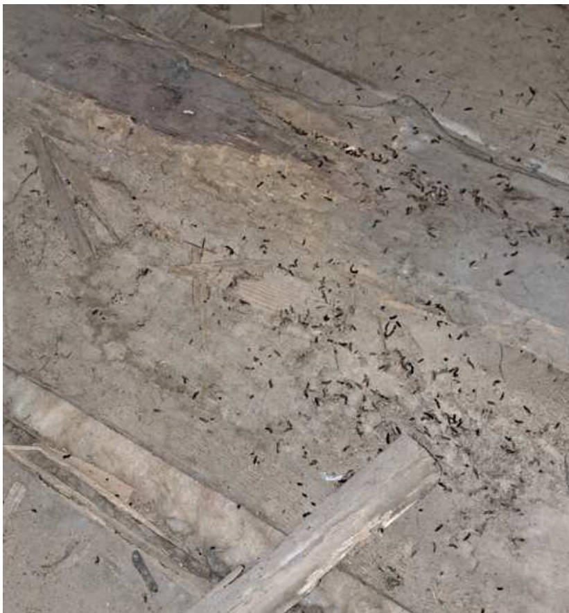
Fot. 14. Podłoga z desek uszkodzona przez ksylofagi.
