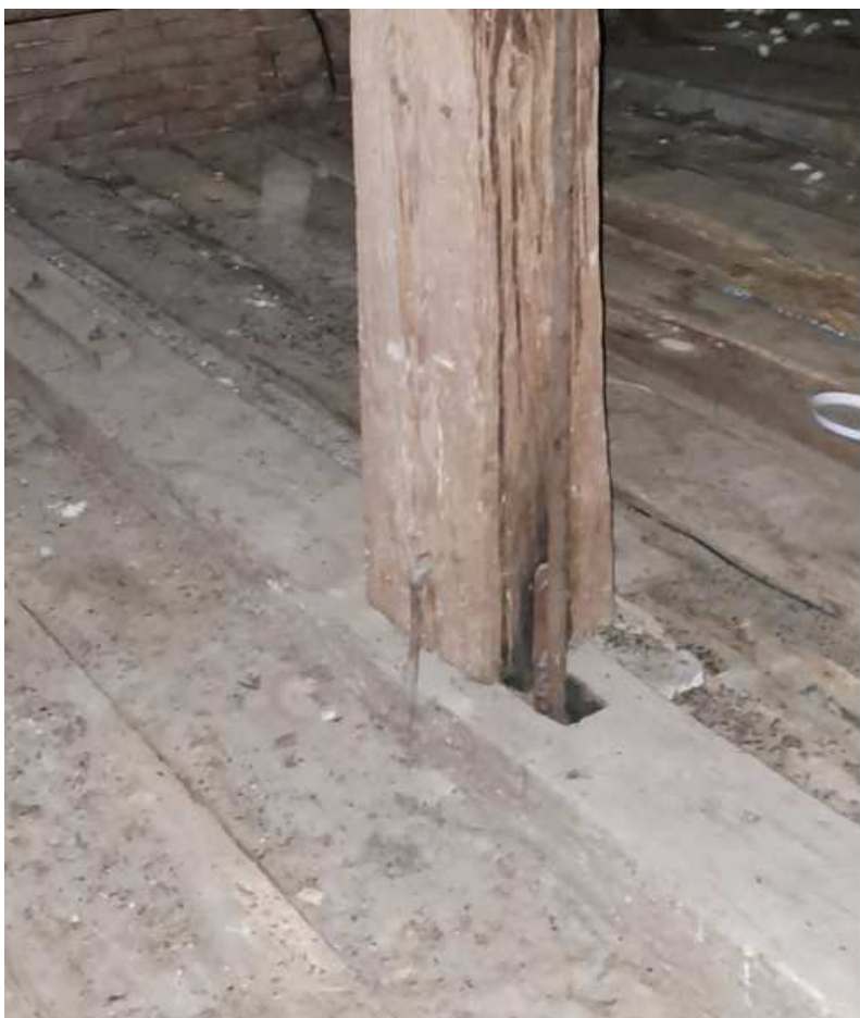
Fot. 11. Przebarwienia i grzyby pleśniowe u podstawy słupa.
