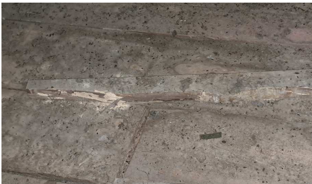
Fot. 17. Sypiące drewno z odchodami świadczące o czynnym żerowisku ksylofagów.
