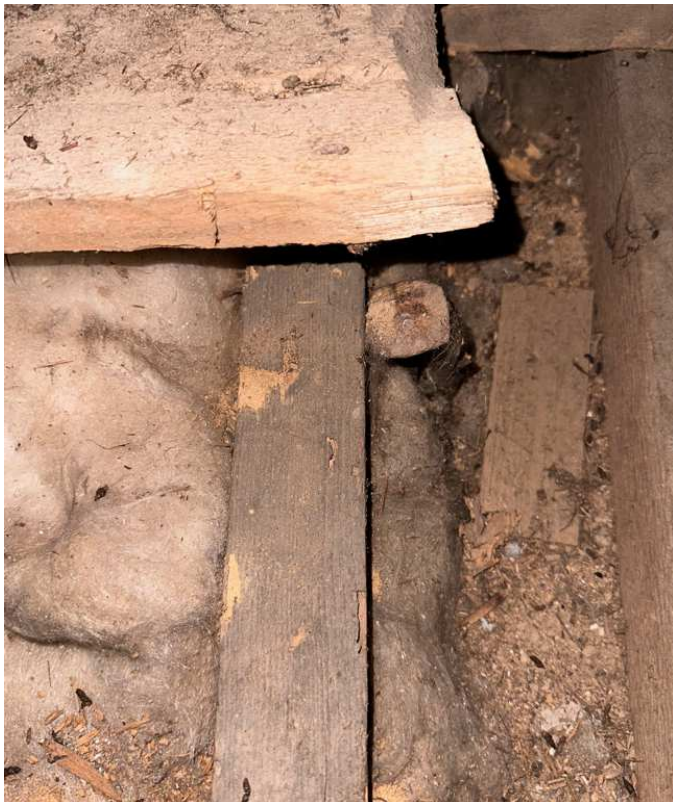
Fot. 15. Elementy podłogi z widocznymi uszkodzeniami przez kołatka domowego (mączka drzewna)
