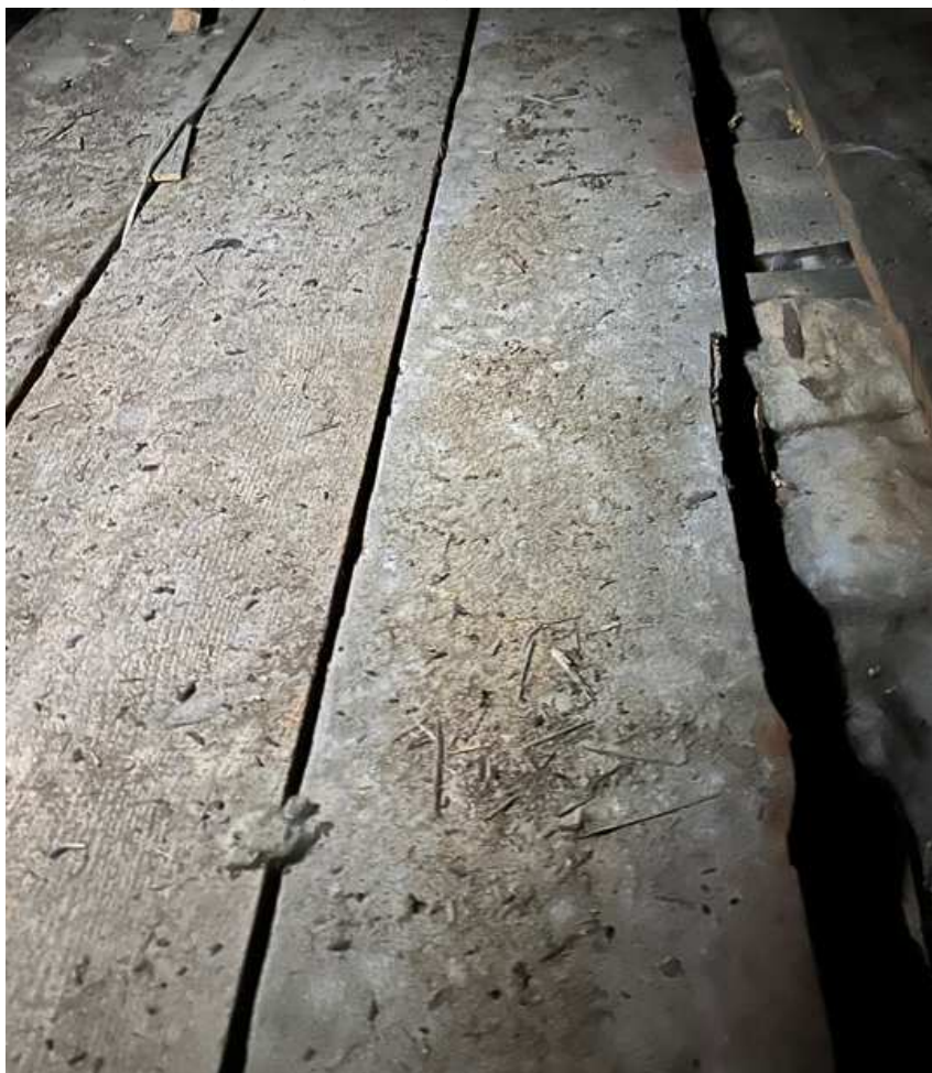
Fot. 16. Sypiące drewno z odchodami świadczące o czynnym żerowisku ksylofagów.
