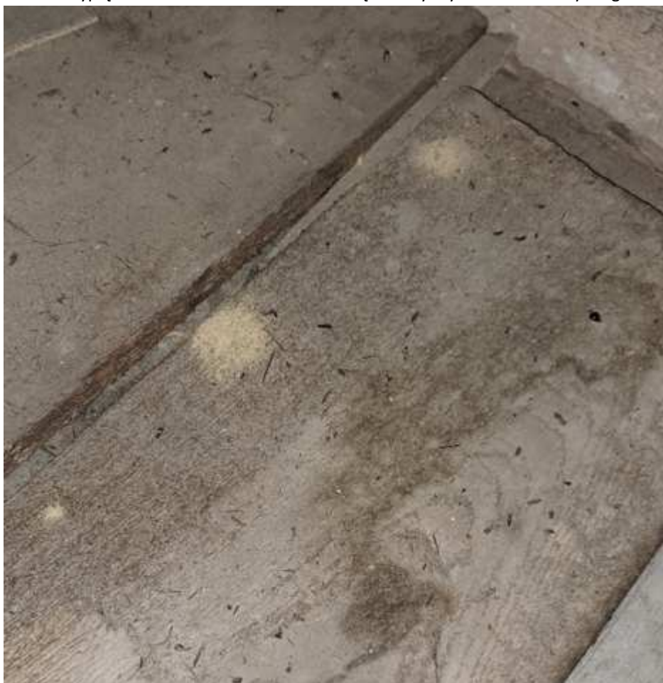
Fot. 18. Sypiące drewno z odchodami świadczące o czynnym żerowisku ksylofagów.
