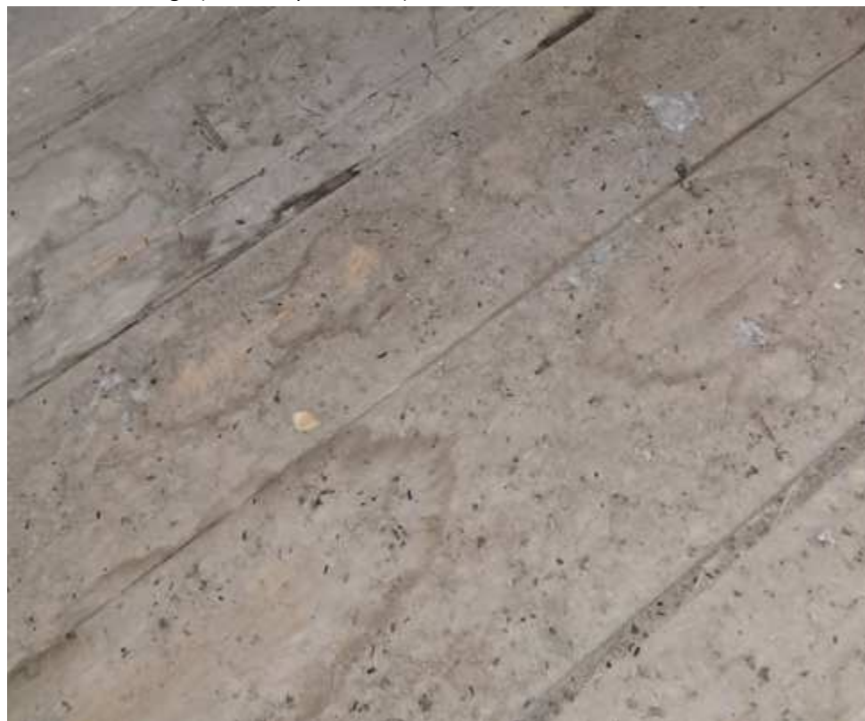
Fot. 12. Podłoga z desek ze śladami zawilgocenia.
