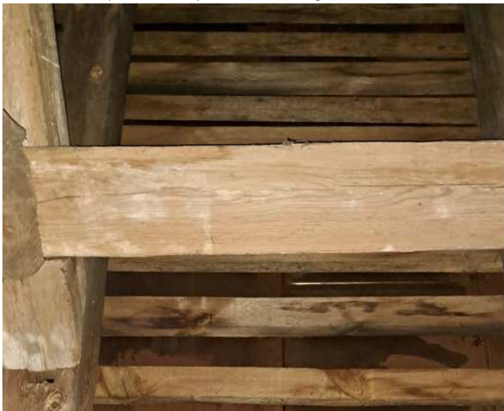
Fot. 3. Grzyby pleśniowe na elementach węzła konstrukcyjnego.
