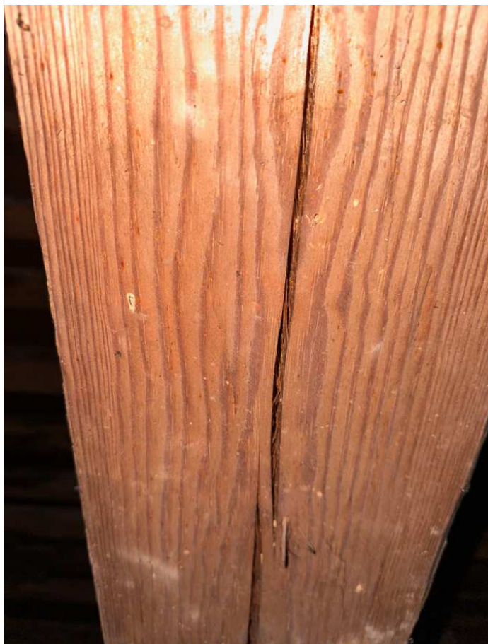
Fot. 6. Krokiew z widocznym występowaniem kołatka domowego.
