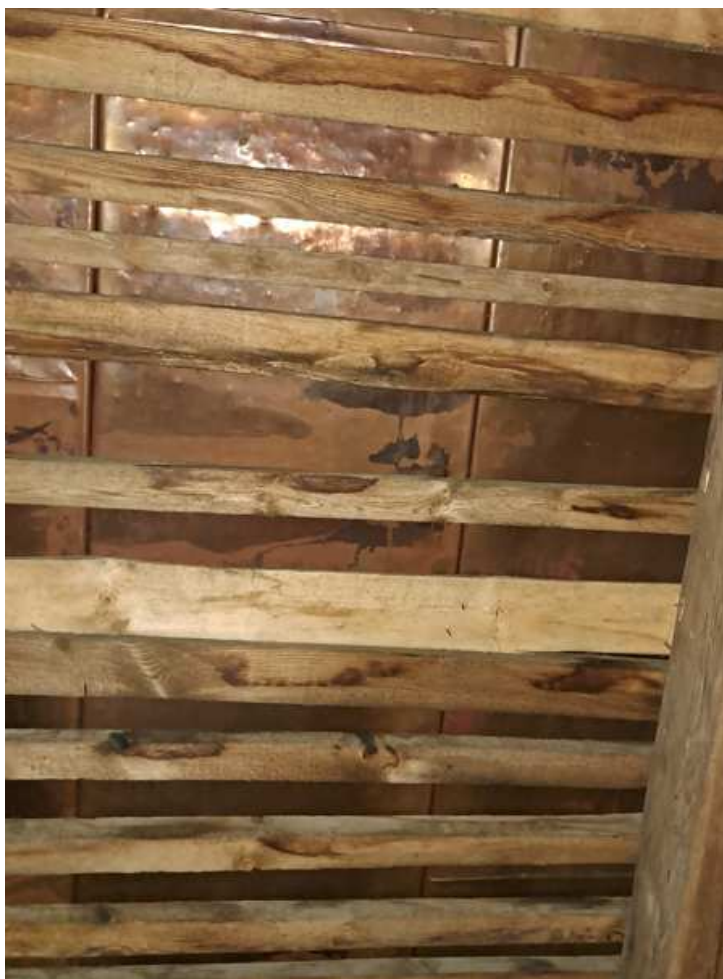
Fot. 4. Zacieki, zawilgocenia i grzyby pleśniowe na deskowaniu dachowym.
