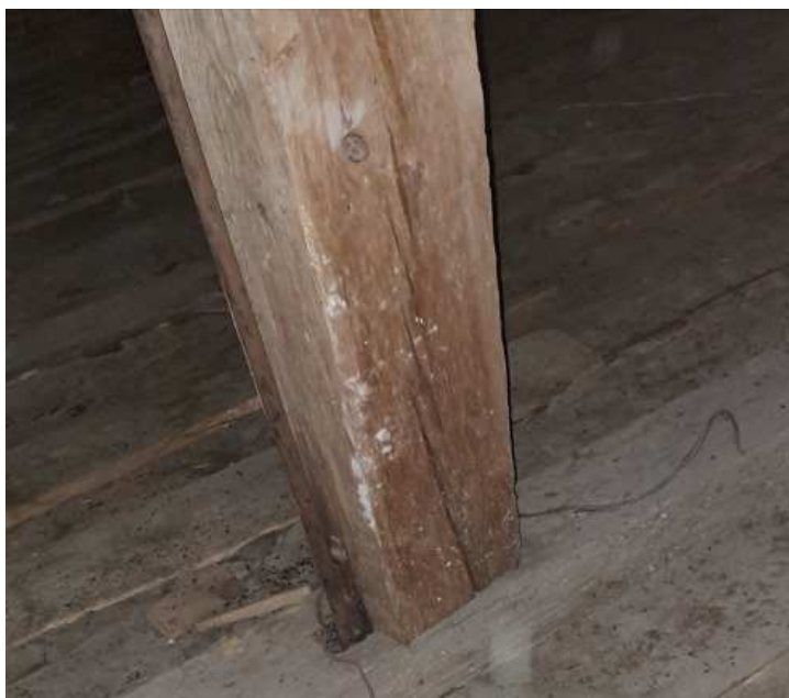
Fot. 2. Podstawa słupa zaatakowana przez kołatka domowego.
